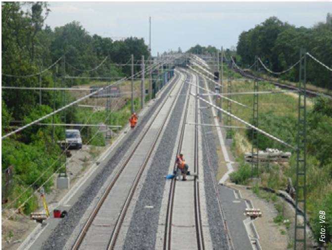
Fertigstellung der Dresdner Bahn zwischen Berlin-Südkreuz und Blankenfelde
