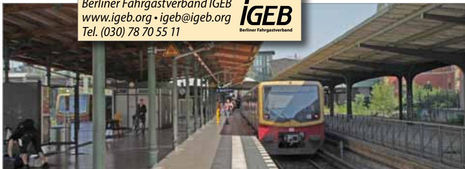
S-Bahnhof Westend auf dem Ring. Obwohl ein zweiter Bahnsteig für ein drittes Gleis noch aus alter Zeit vorhanden ist, ist er nicht zum Zugtausch geeignet. Das dritte Gleis ist nicht wieder aufgebaut worden. Gefordert wird dies seit vielen Jahren.
