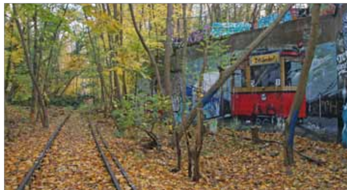
In den fast 40 Jahren seit Einstellung des S-Bahn-Verkehrs Zehlendorf—Düppel sind die Gleisanlagen überwachsen. Nur das Wandbild erinnert noch an die alte Zeit.
