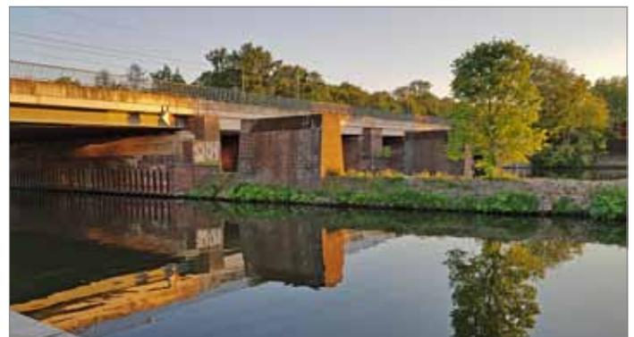
Die Spreebrücke der Ringbahn am Bahnhof Jungfernheide. Über die ungenutzten Brückenpfeiler führen bis 1980 die Ring-S-Bahn- und Siemensbahn-Züge.
